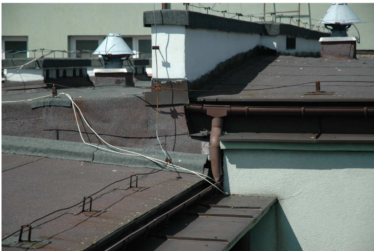
Zbliżenie narożnika do montażu szybu. Widoczna rynna do przesunięcia
